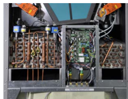
Rysunek: wymienniki ciepła i zbiorniki na skropliny
