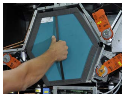
Rysunek: przeciwaprądowy wymiennik ciepła
